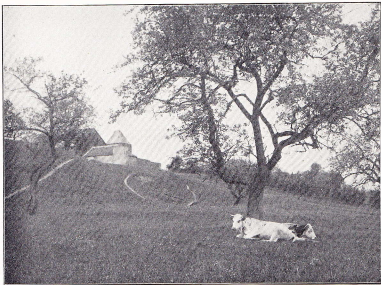
CORROY-LE-GRAND — Le château
